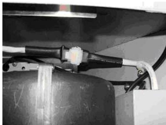
2. Branchez le connecteur mâle à six fiches du câblage du ventilateur externe dans le connecteur femelle à six fiches du tableau de commande à l'intérieur du bloc d'alimentation (la prise est située à l'intérieur du bloc d'alimentation, elle dépasse du boîtier blanc du tableau de commande).
